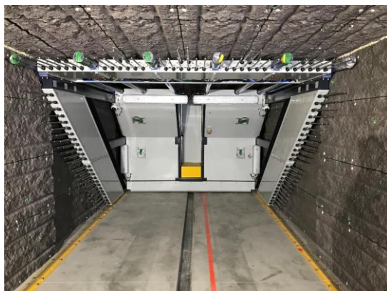
Équipement de pose de la bentonite granulaire vue de l'intérieur d'une galerie souterraine factive
