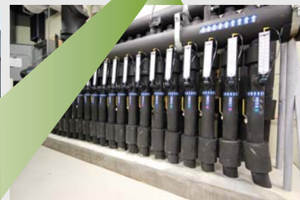
Arrivée et retour des boucles de géothermie
