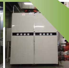
Thermopompe centralisée
